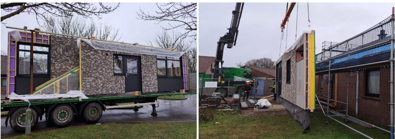
Figuur 11 Voorbeeld van geprefabriceerde renovatie-elementen in het oPEN Lab-project, gecoördineerd door VITO (Genk)
